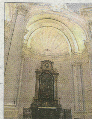
...e dopo l'intervento
